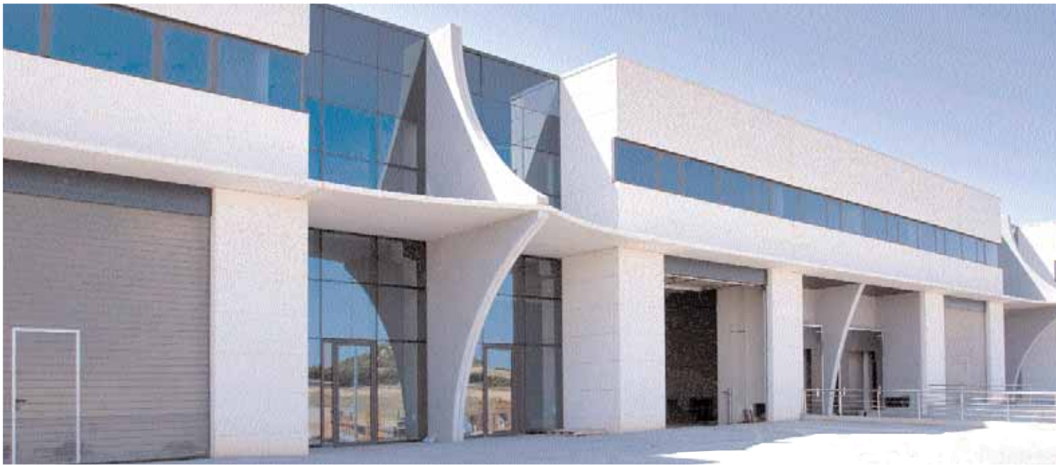
IMAGEN EN DETALLE DE LAS NAVES DESTINADAS A ACOGER NUEVOS PROYECTOS Y QUE, ADEMÁS, ALBERGAN EL VIVERO DE EMPRESAS EN LA CIUDAD AGROALIMENTARIA - CAT DE TUDELA
