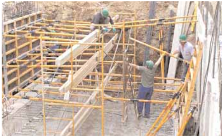
LA FORMACIÓN ES ESENCIAL PARA EVITAR ACCIDENTES LABORALES EN LA CONSTRUCCIÓN
